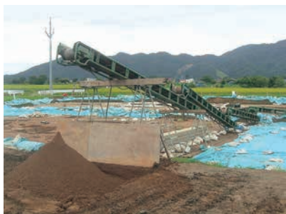
旧 朝日村内 現場
