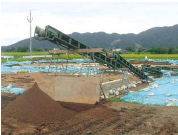
旧 朝日村内 現場
